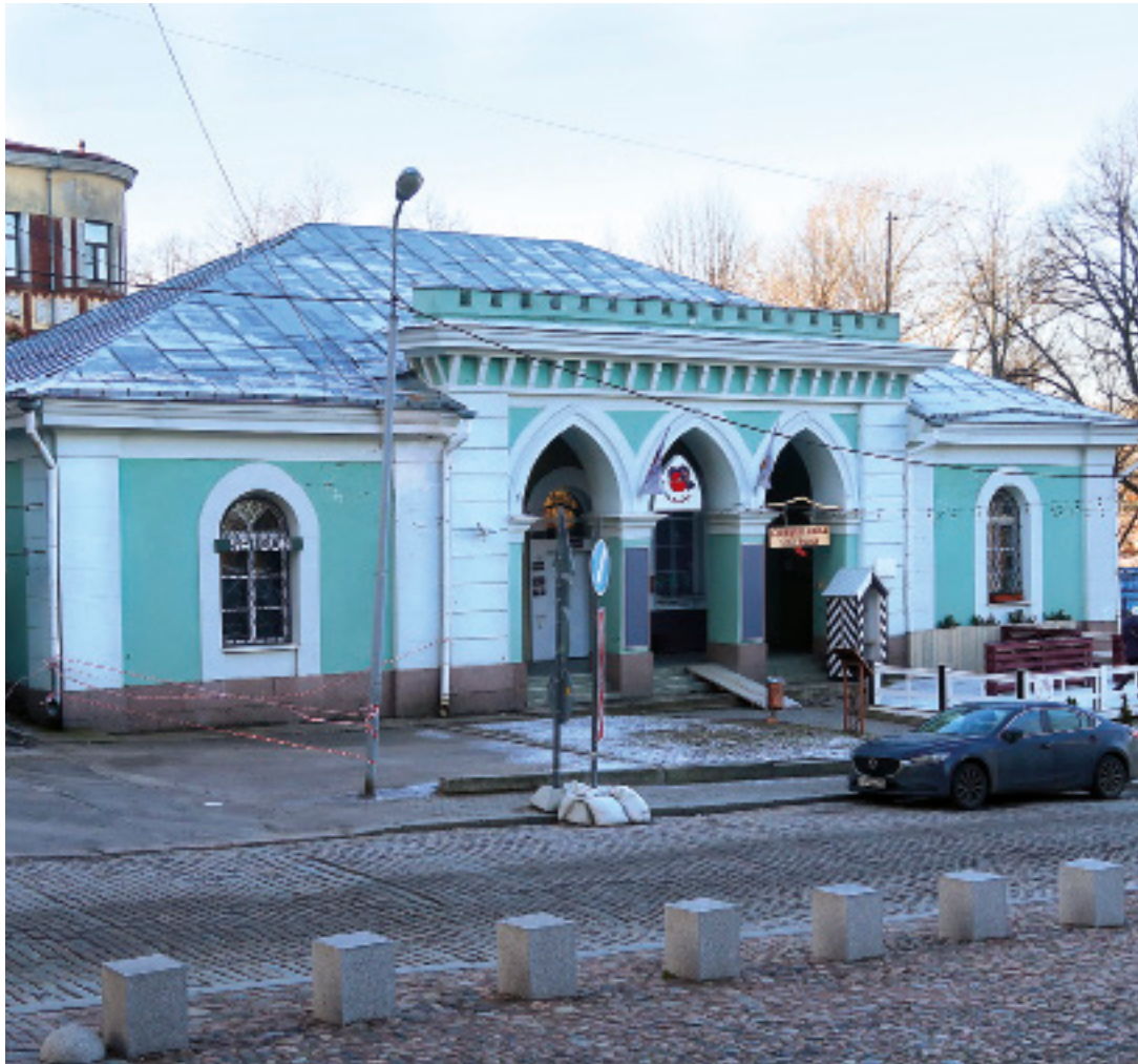
Päävartion rakennus on Linnansillan kupeessa. Krimin sodan aikana vuosina 1854–1856 kaupungin portit suljettiin yöksi, ja rakennuksen edessä seisneiden sotilaiden tehtävänä oli tarkistaa portin läpi kaupunkiin pyrkineiden kulkuluvat.
